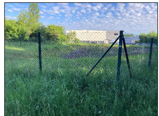
Abb. 20: Regenrückhaltebecken mit Umzäunung (eigene Aufnahme 05/2025).
