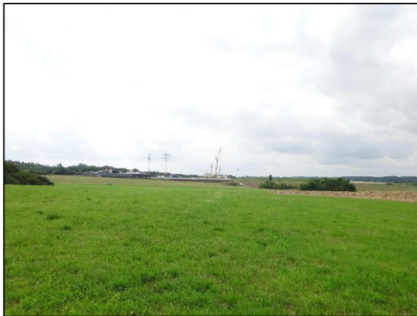
Abb. 19: Blick aus dem westlichen Teilgeltungsbereich in südliche Richtung (Aufnahme 08/2025).
