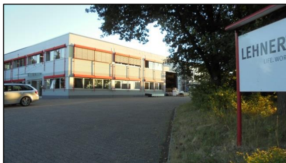
Gewerbliche Nutzung (Halle/Gebäude).
