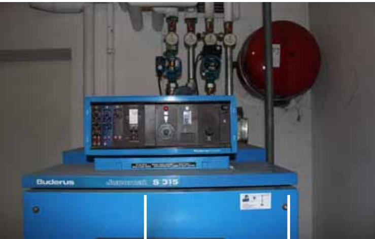
Grundsätzlich ist es ratsam, eine Gas- oder Ölheizung auszutauschen, wenn sie noch nicht mit der modernen Brennwerttechnik ausgestattet ist. Hierdurch kann ca. ein Drittel der Energiekosten eingespart werden.
