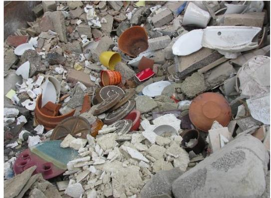
Der Bauschutt wird direkt zu ortsnahen Bauschutt- Verarbeitern gefahren und dient zum Beispiel als standfester Untergrund für den Straßenbau.
